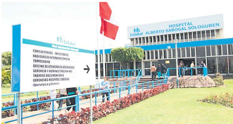
MÁQUINAS DE LOS NOSOCOMIOS GUILLERMO ALMENARA Y ALBERTO SABOGAL LLEVAN SEMANAS INOPERATIVAS.
